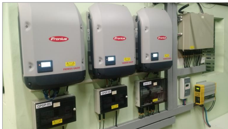
FIGURA 2 – Sistema de operação: inversores, quadros de força, controlador de carga e banco de baterias.
