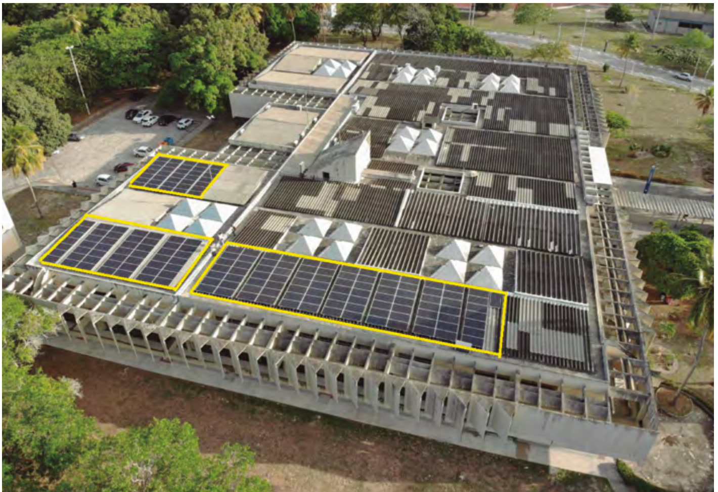
Figura 2 - Sistema Fotovoltaico Conectado à Rede – BICEN. Fonte: Eficiência Energética (2018).
